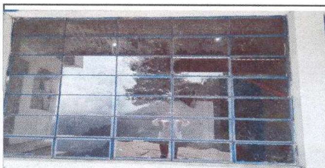
Foto 5: fabricacion e instalacion de balcon de metal
