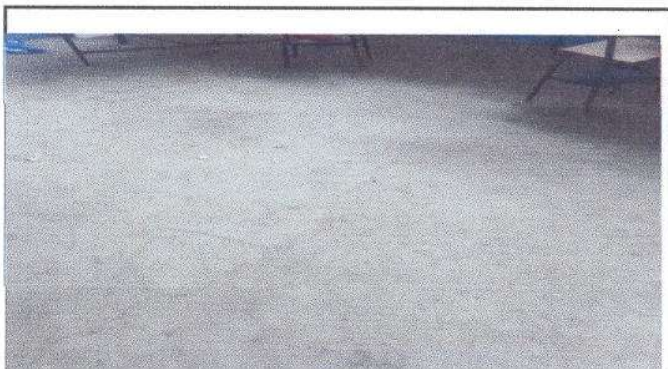
Foto 3: sustitucion de piso de ceramico
