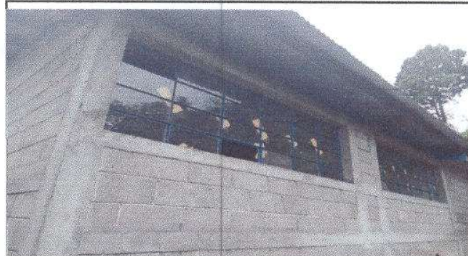
Foto 2: Sustitucion de vidrios
