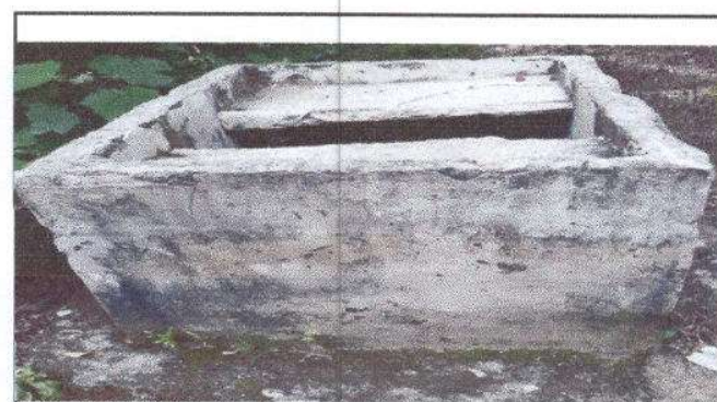
Foto 6: Sustitucion de pila plastica de dos lavaderos
